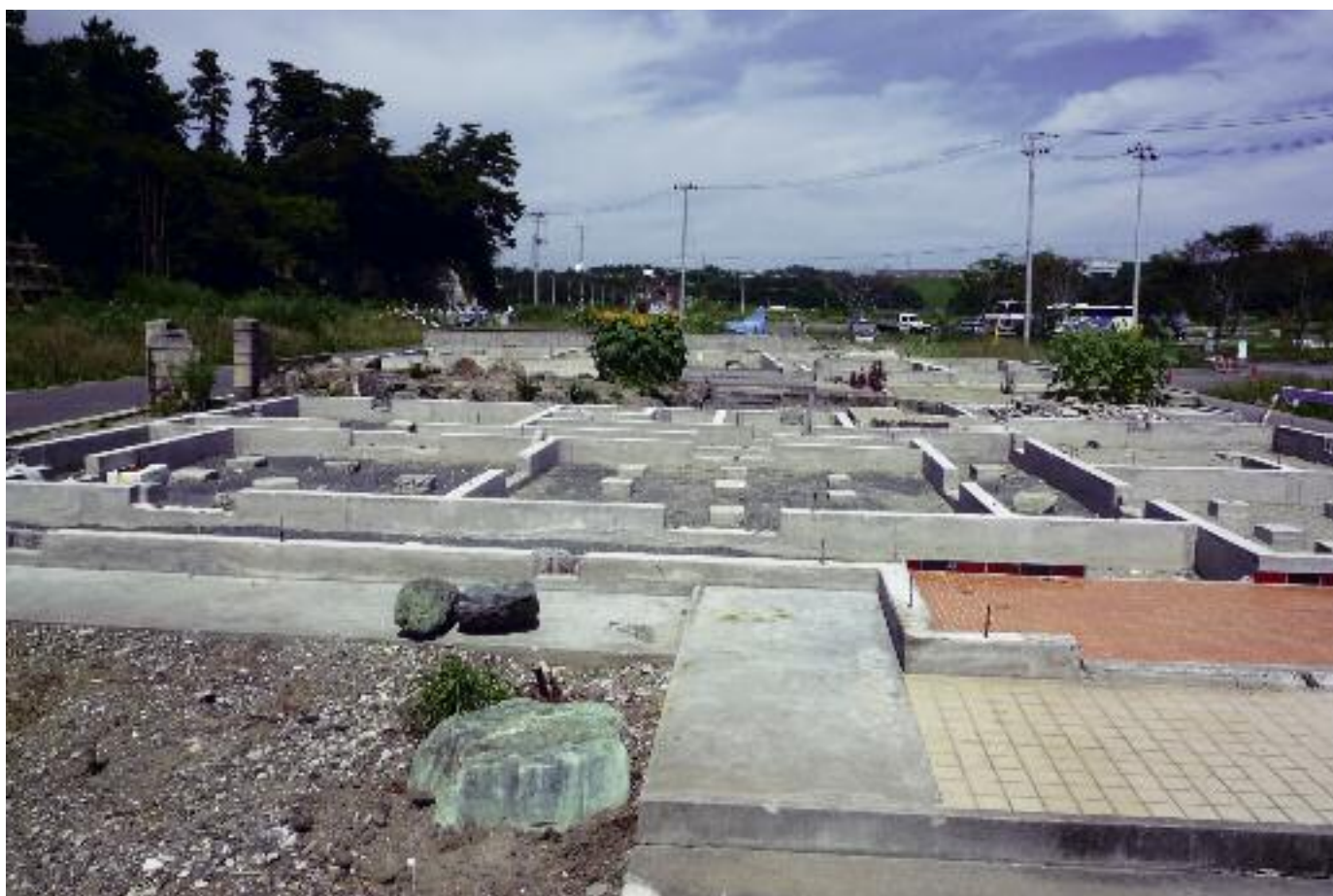
Tsunamivågen var på sina håll över 30 meter hög. Här har den sopat med sig husen och endast lämnat grunderna kvar.
