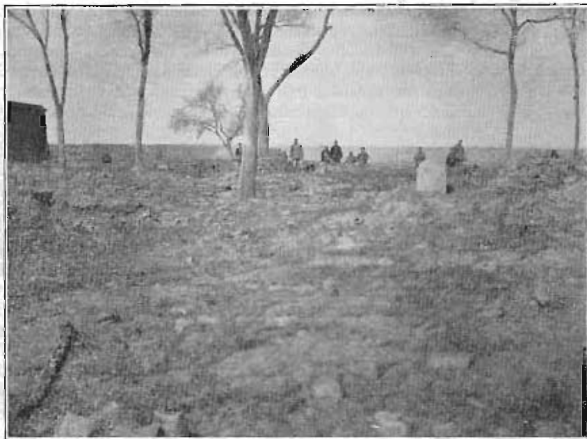
På tomten för nya kapellet i Puchow vid röjningsarbetets början.
